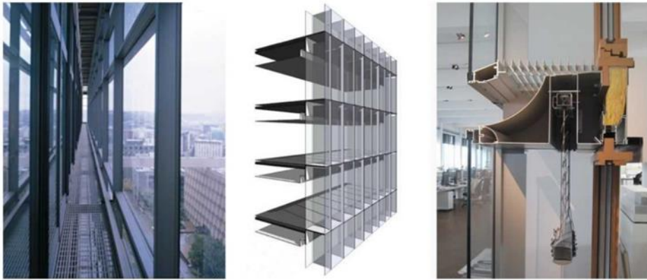
شكل (7) وجود ستائر معدنية لكي تستغل أيضا SHADING DEVICE
